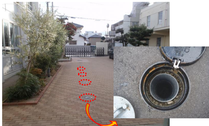
マンホールトイレの設置状況 (例)
